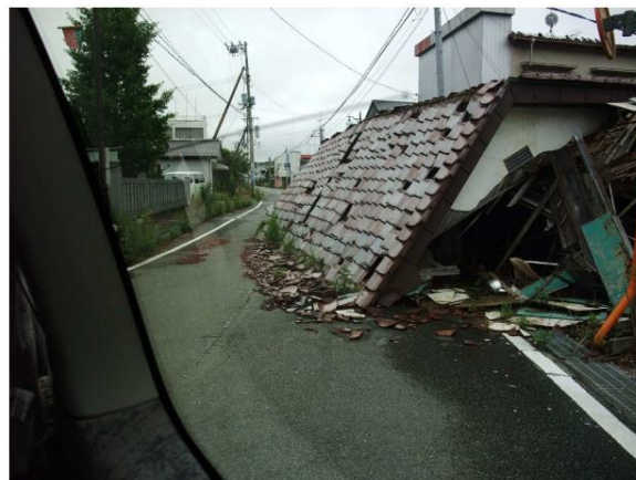
Route principale à 3km du site accidenté de Fukushima. 25 juillet 2013
